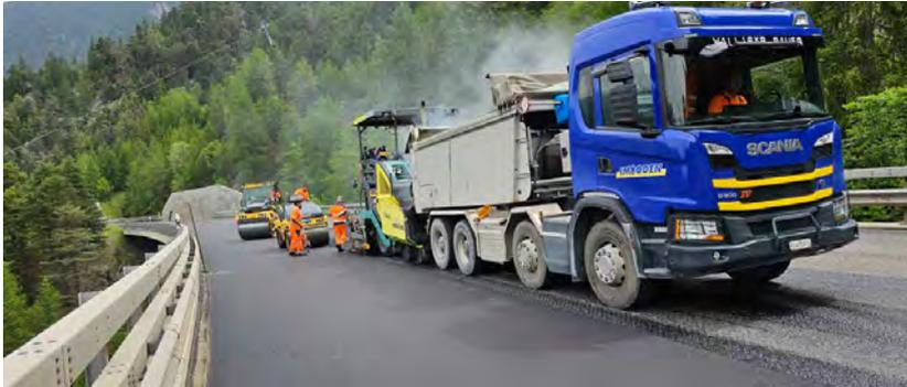
Anfangs Jahr bekamen wir vom Kanton den Auftrag, diverse Abschnitte bei Brückenauflegern auf der Simplonpassstrasse zu erneuern. Dabei wurden die Belagsabschnitte saniert, indem die Deckschicht abgefräst und neu eingebaut wurde. Direkt dahinter sind durch eine Spezialfirma die definitiven Fahr-
