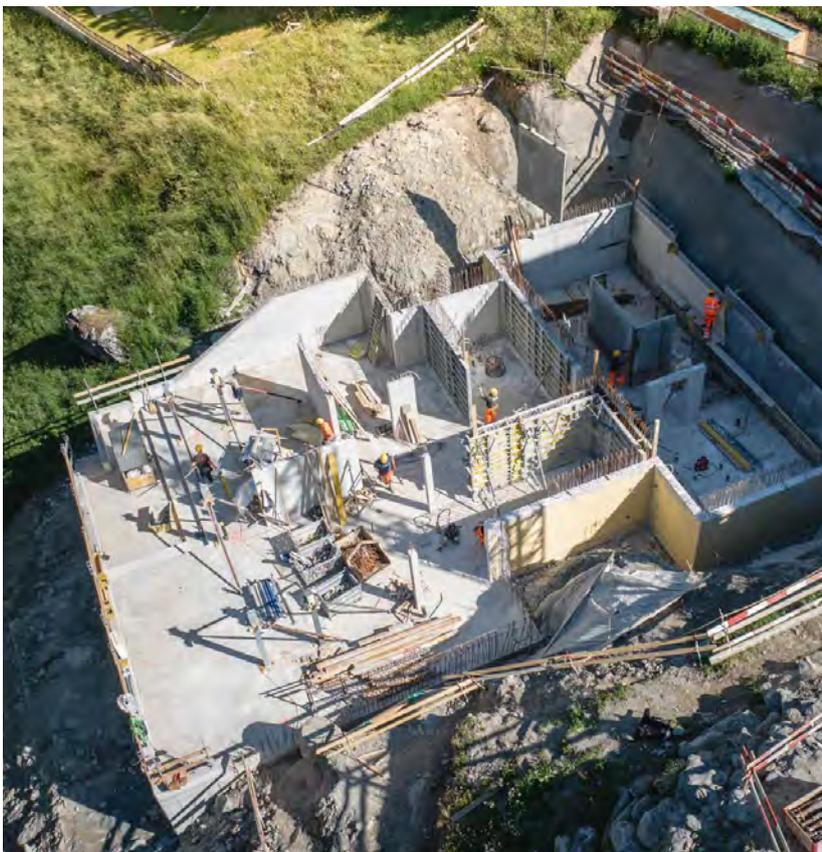
eingeschränkt war, musste vor Ort mit Ingenieur und Geologe eine passende Ausführung gewählt werden. Im letzten Herbst konnten die Aushubarbeiten starten. Zeitgleich wurden Teile der Baustelleneinrichtung installiert. Für diese Baustelle steht ein GHS-Kran, welcher mittels Air-Zermatt geflogen werden kann, im Einsatz. Der neue Kran ist flexibler und leichter und kann so einfacher mit dem Heli gesetzt werden. Dies ist wegen den engen Platzverhältnissen in Zermatt immer notwendiger.
