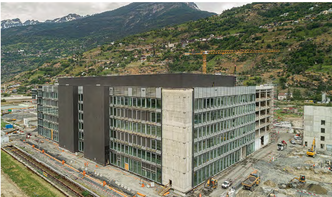
Terbinerstrasse in Visp
